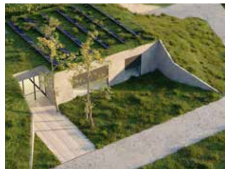
Laboratorium Eko Dom Energia powstanie na terenie Kampusu przy ulicy Rudzkiej
