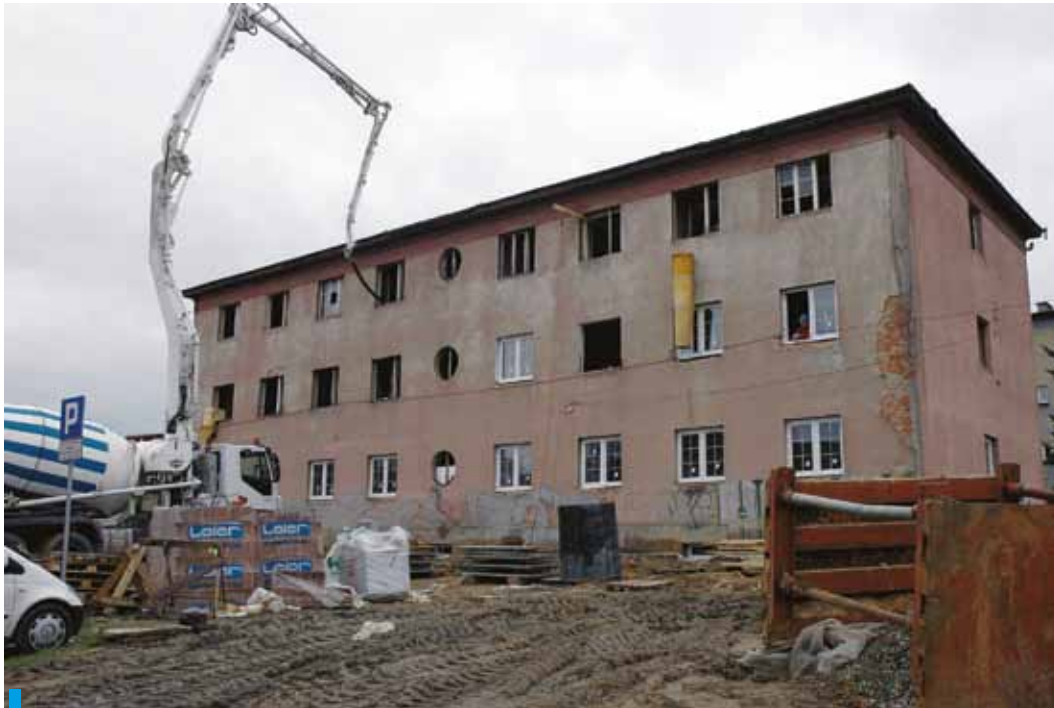
W bloku 31a przy ul. Zebrzydowickiej trwa gruntowny remont. Pierwsi lokatorzy wprowadzą się tu jesienią przyszłego roku
