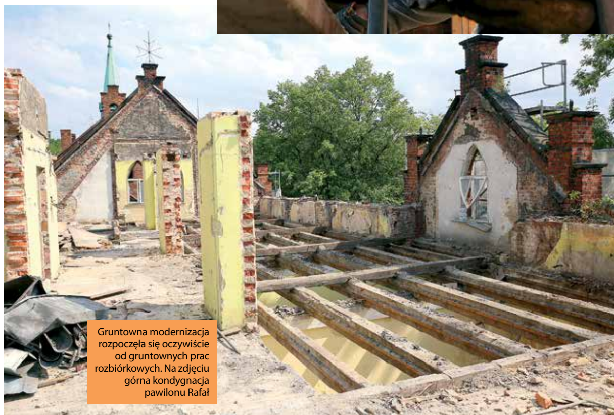
W drugiej połowie sierpnia trwała już budowa nowej więźby łącznika pomiędzy pawilonami Rafał i Juliusz, który zdobi figura Chrystusa
