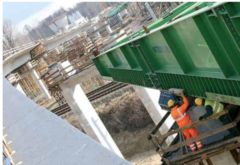
Na czole nasuwanego na filary wiaduktu znajduje się ułatwiający manewrowanie betonowym kolosem tzw. stalowy dziób, który wkrótce zostanie zdemontowany
