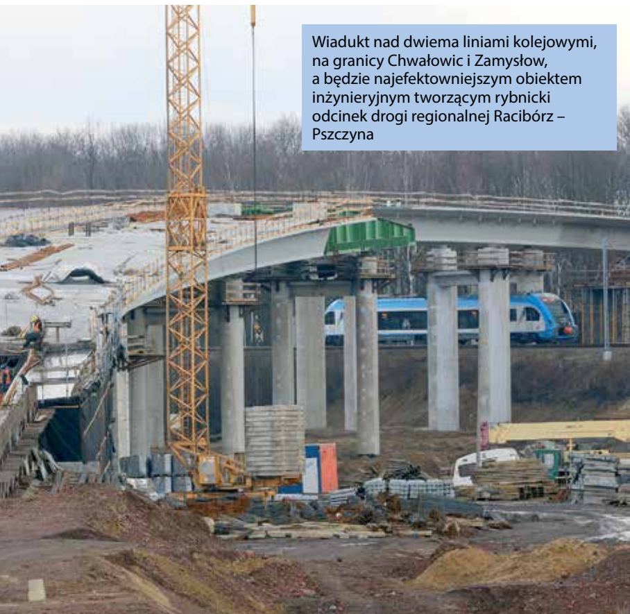
Na czole nasuwanego na filary wiaduktu znajduje się ułatwiający manewrowanie betonowym kolosem tzw. stalowy dziób, który wkrótce zostanie zdemontowany
