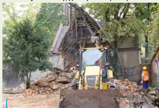
3 września g. 14.05. Prace wyburzeniowe
