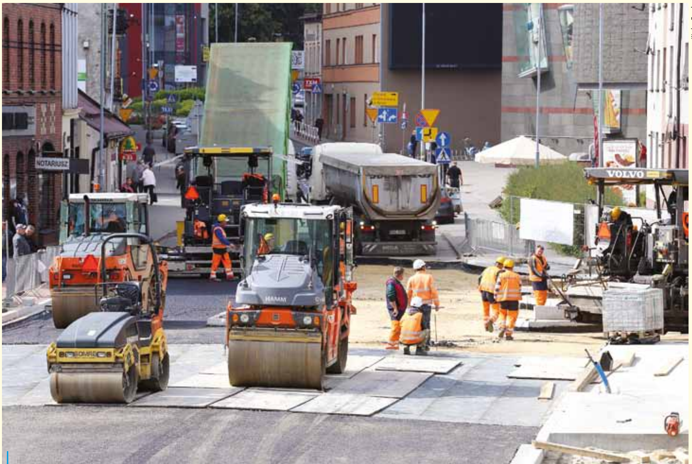
Modernizację mostu na ul. Raciborskiej poszerzono o lifting fragmentów dróg dojazdowych, gdzie położono nową nawierzchnię
