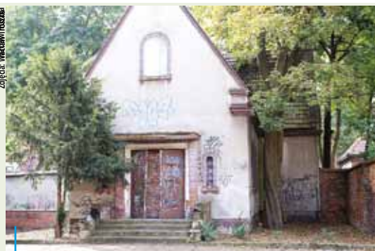
3 września g. 9.02. Nieistniejący już budynek dawnej kostnicy
