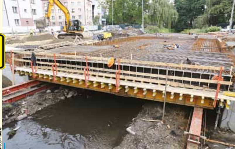
Nowy most na Nacynie nabiera kształtów; będzie przejezdny w połowie października
