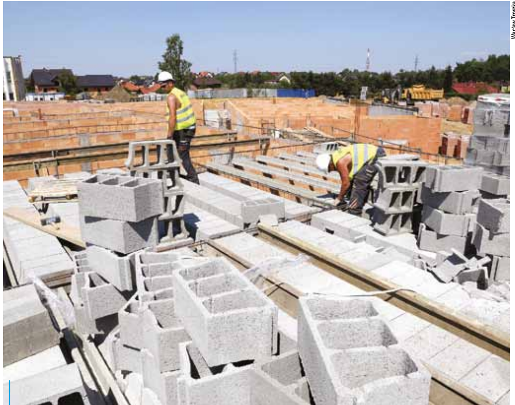
Mury przedszkola już stoją, właśnie rozpoczęto układanie stropów z gotowych elementów
