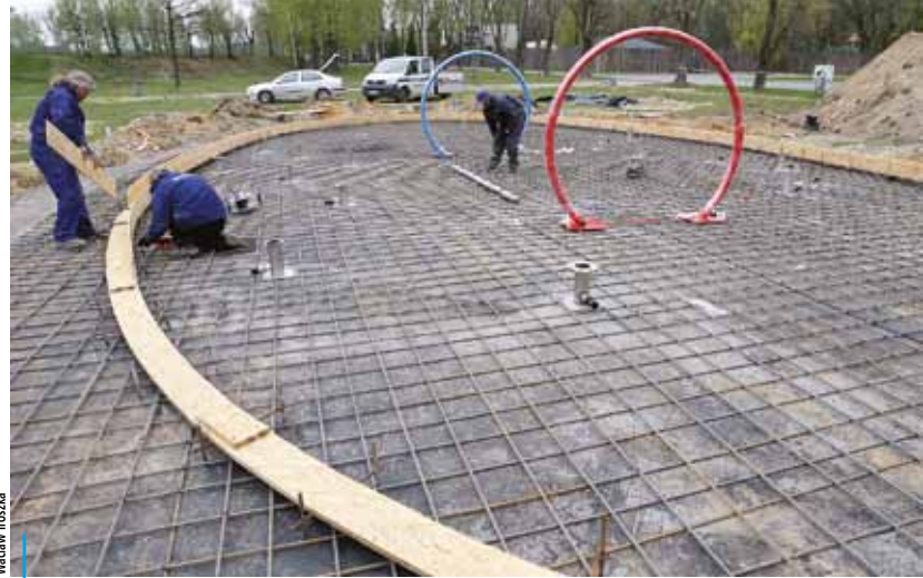
W ośrodku w Kamieniu trwa budowa pluskadelki, czyli wodnego placu zabaw dla najmłodszych
