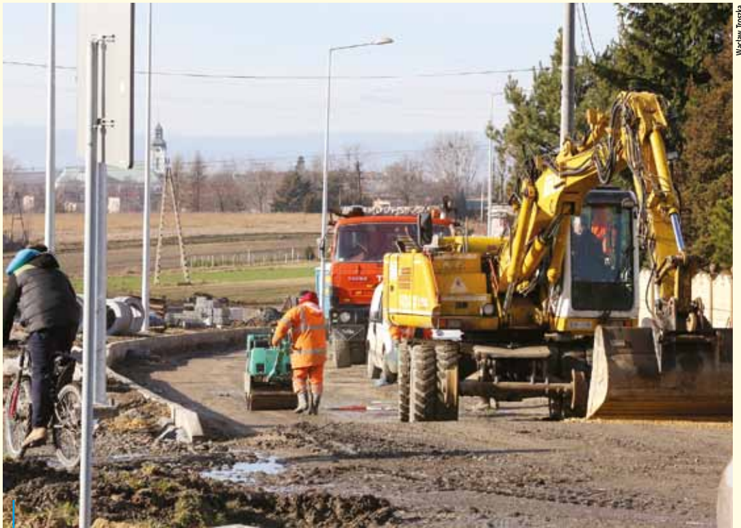
Na ul. Zwycięstwa w Chwałowicach trwa budowa nowej podbudowy tej drogi
