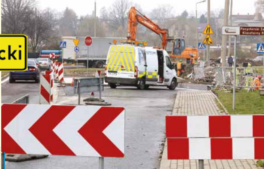
Przebudowa ronda Boguszowickiego jest związana z powstaniem w sąsiedztwie stacji paliw
