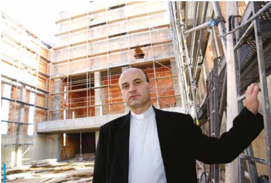
Ks. Marek Bernacki ma nadzieję, że przed Bożym Narodzeniem kościelne mury przy ul. Pilarczyka zostaną przykryte dachem
