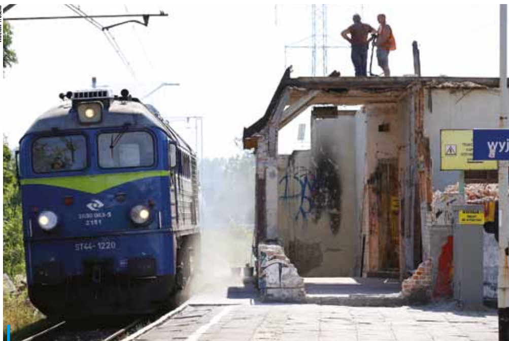
Pierwszy etap prac bardziej przypominał rozbiorę stacji niż jej remont
