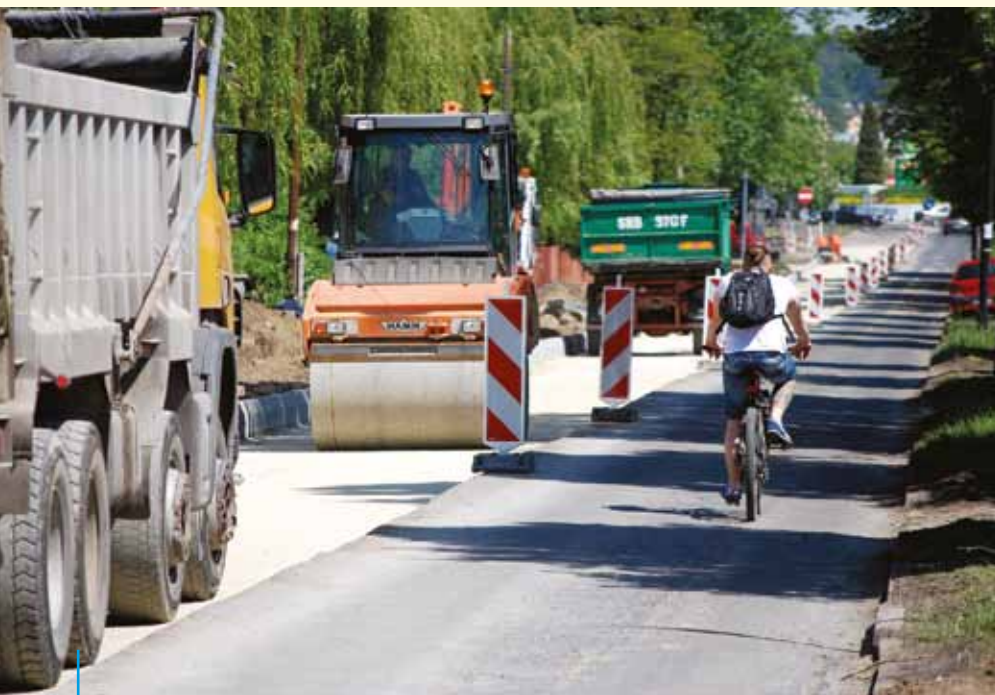
W czasie przebudowy na ul. Mikołowskiej obowiązuje ruch jednokierunkowy
