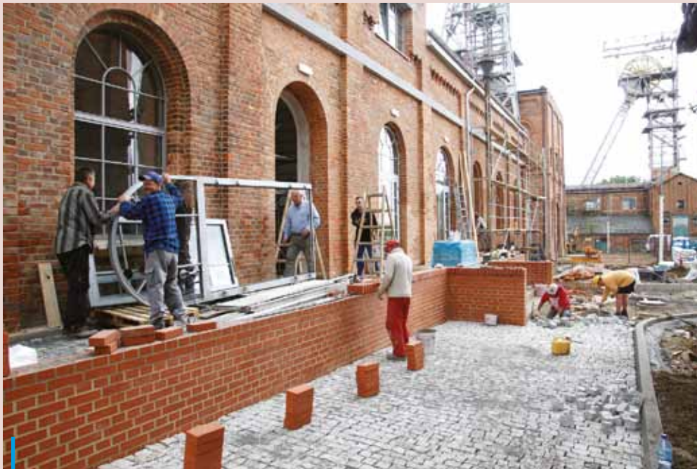
Zaniedbana do niedawna była kopalniana stolarnia wkrótce będzie obiektem iscie reprezentacyjnym
