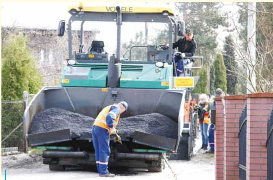
W kwietniu Rybnickie Służby Komunalne ułożyły asfaltową nawierzchnię na ulicy Rybackiej w Rybnickiej Kuźni
