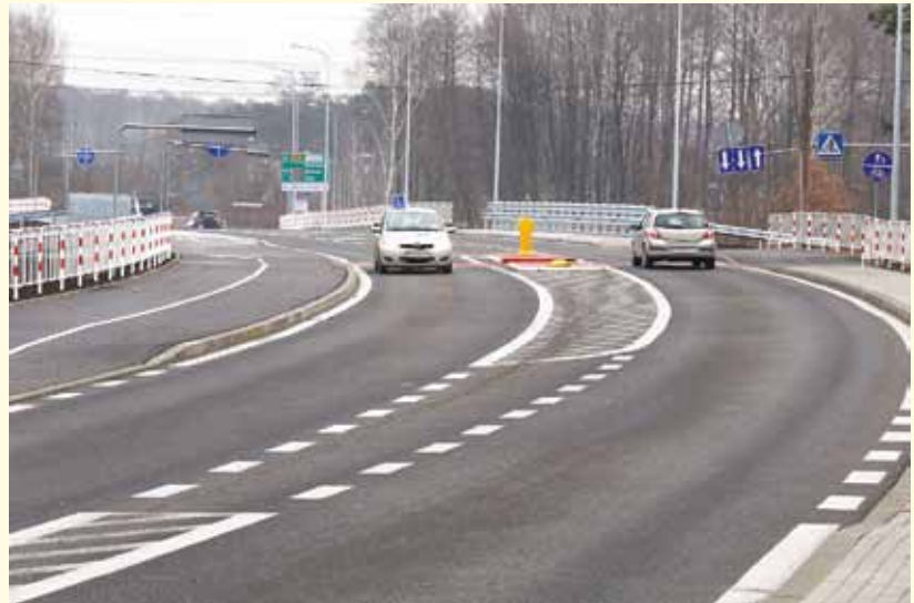
Oddany po modernizacji odcinek ul. Rudzkiej na wysokości oczyszczalni ścieków
