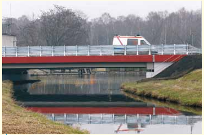
Nowy most na Nacywie w ciągu ul. Rudzkiej
