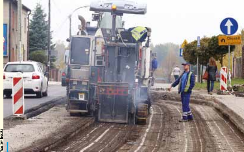
Końcowa faza robót na ul. 1 Maja w Chwałowicach
