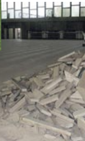
Wymiana parkietu jest już ukończona.
