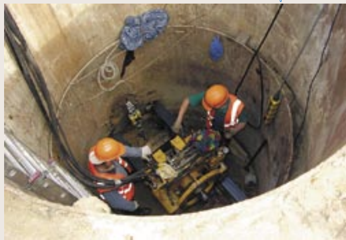
Ligota-Ligocka Kuźnia – roboty wykonywane metodą bezywkopową na ul. Wolnej.
