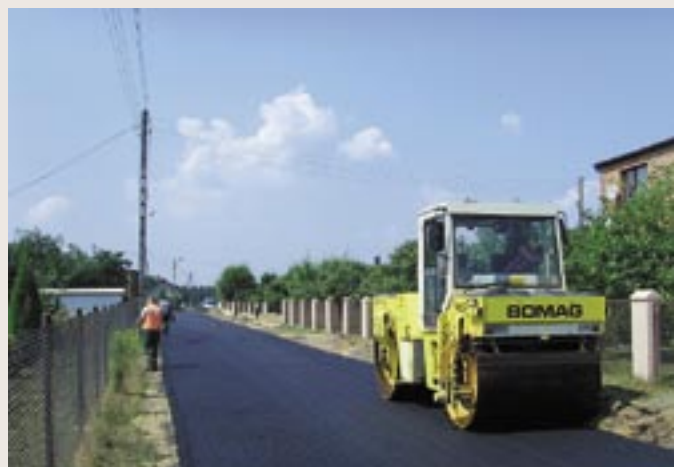
Ochojec – roboty asfaltowe na ul. Cystersów. Zdj.: Biuro realizacji projektu
